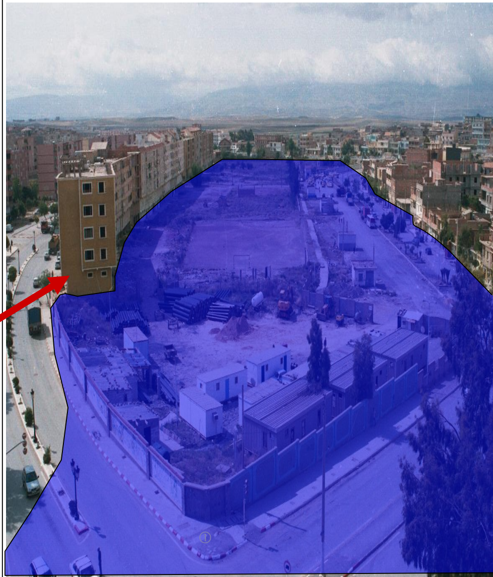
Photo de construction des bâtiments sur une aire de jeux (zone inondable)
