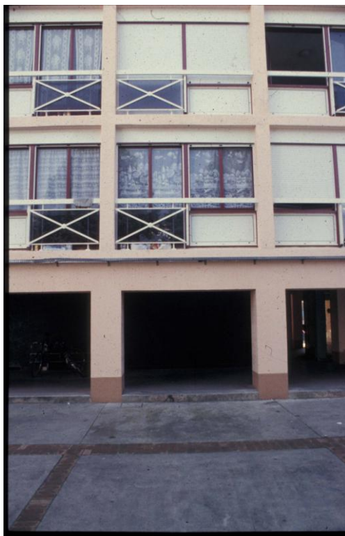
Photographies des façades avant et après les travaux de transformation.
