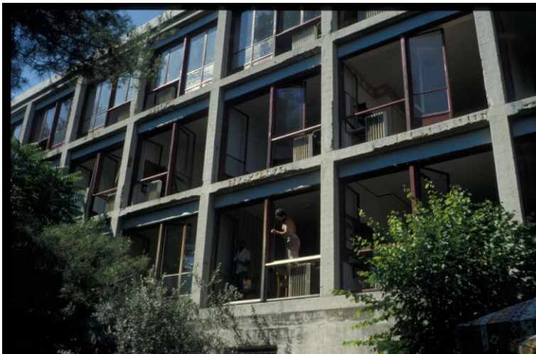
Photographies des immeubles d'habitation pendant les travaux.
