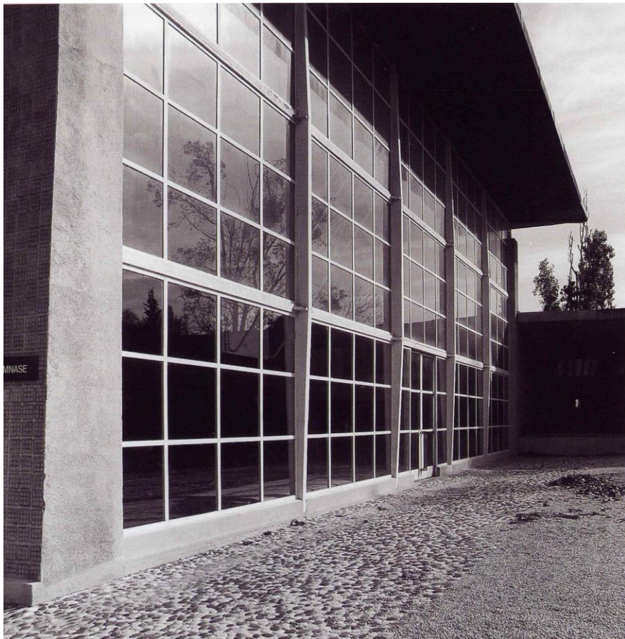
Photographies de la cour et du gymnase avant démolition.
