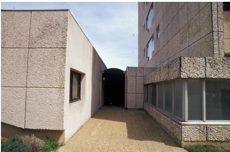
Remplacement des menuiseries (en haut) et extension en rez-de-chaussée.
