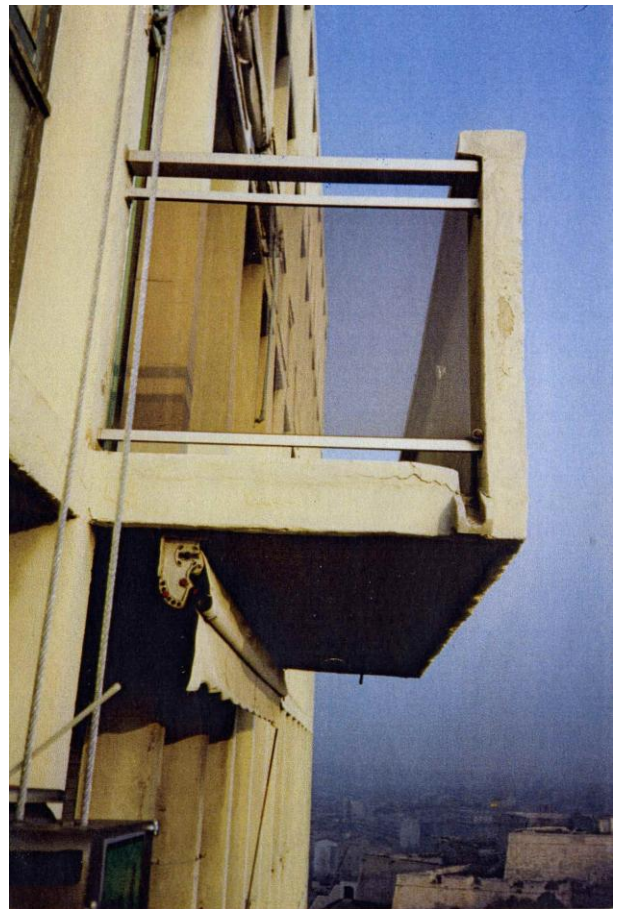
Diagnostic avant travaux du cabinet BEREC.
