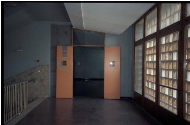
Lycée Colbert : réhabilitation d'un couloir en 1993.
