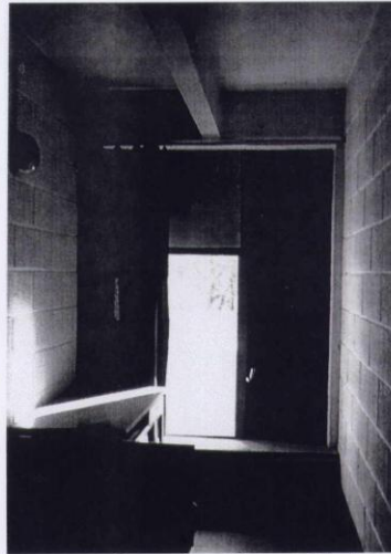
Aménagement des chambres d'internes du lycée
