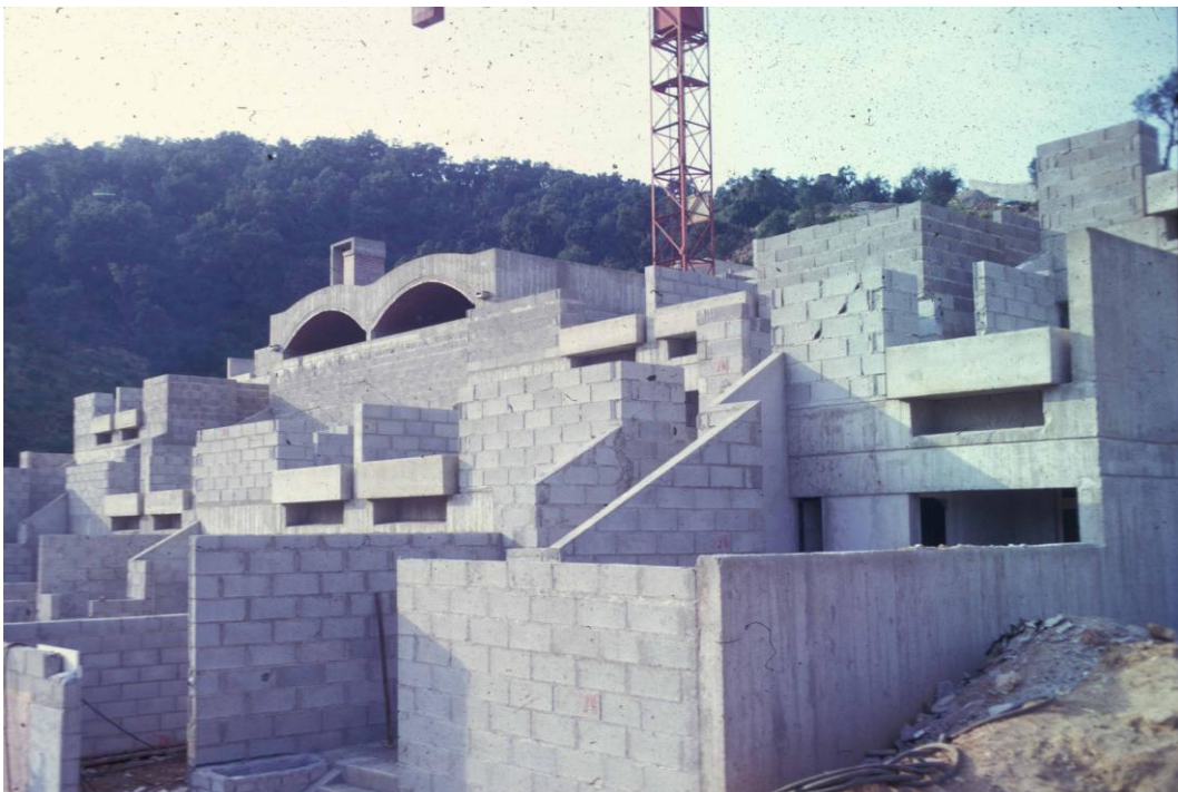
Village de Gassin : première maquette (1965) et photographie du chantier.
