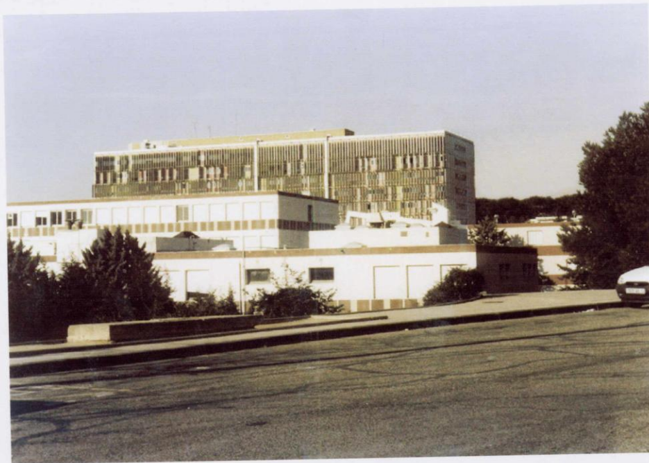
FACADE SUD EST: état des lieux
