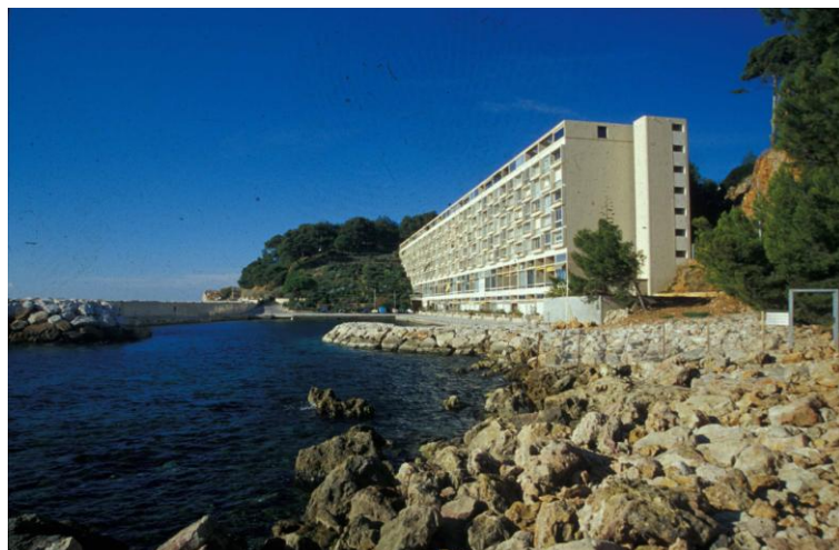
Photographies avant la reprise des façades de l'ensemble d'habitation Athéna Port.
