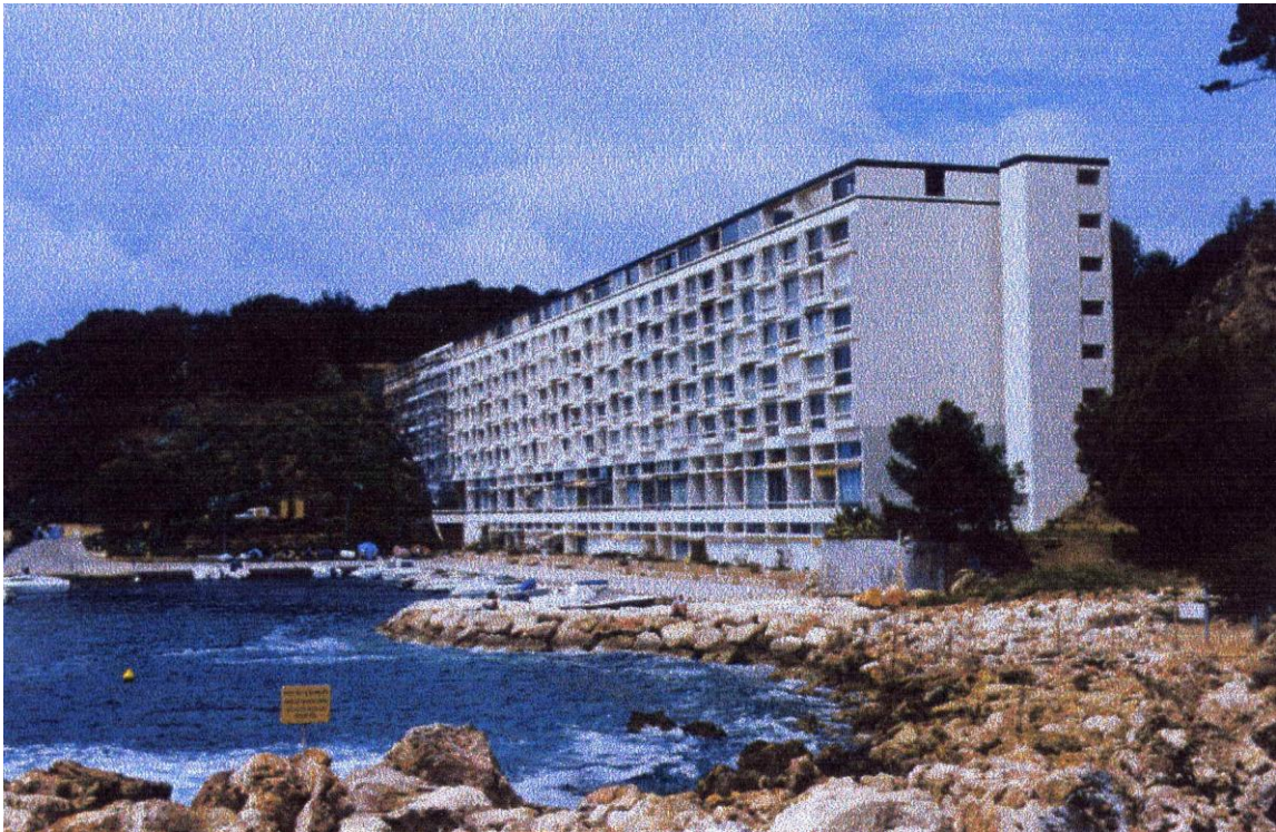
Reprise des peintures de façades. Photographie prise pendant le chantier.
