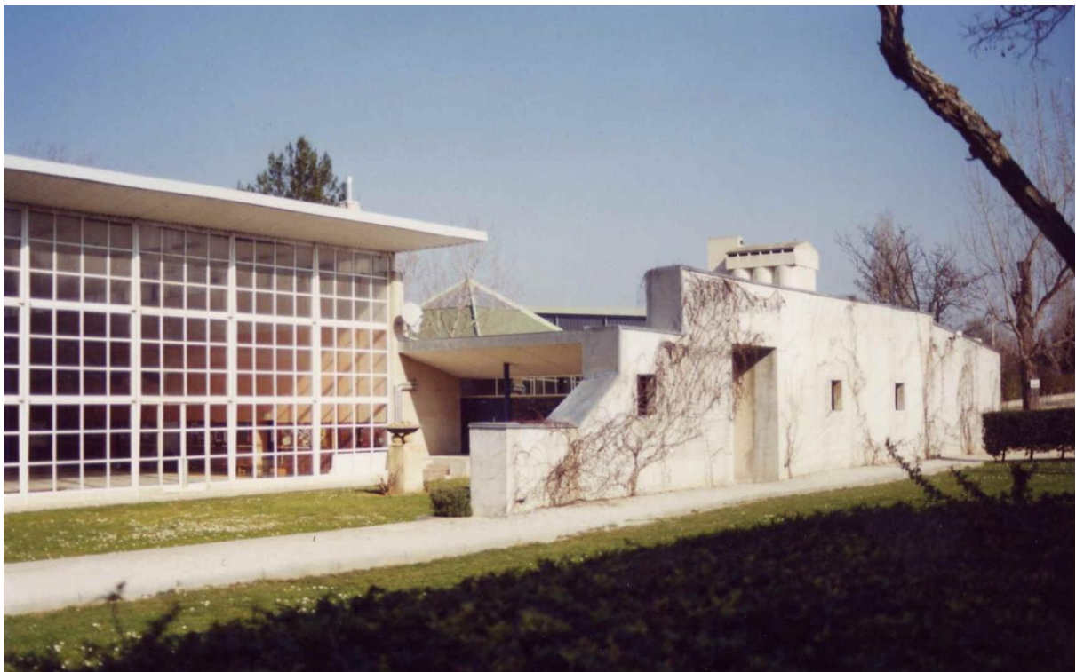
Photographies des reliques de l'aile ancienne d'hébergement.
