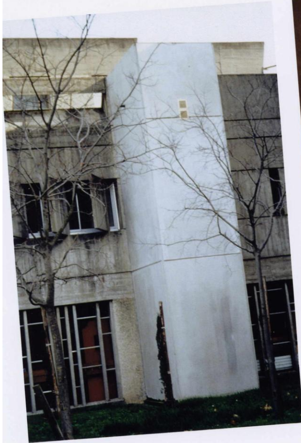
Cage d'ascenseur pour Handicapés (Source : C.D., 2001)
