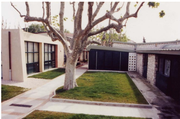
Photographies de l'extension de l'école.
