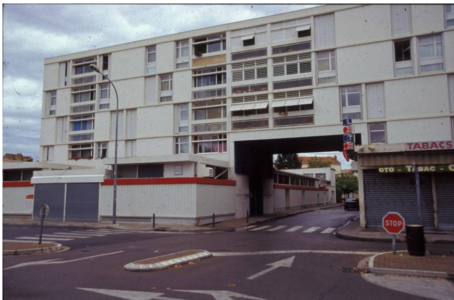
Photographies actuelles après réhabilitation (JL Fulcrand).
