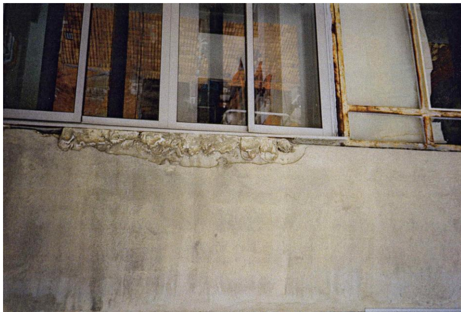
Diagnostic avant travaux du cabinet BEREC.
