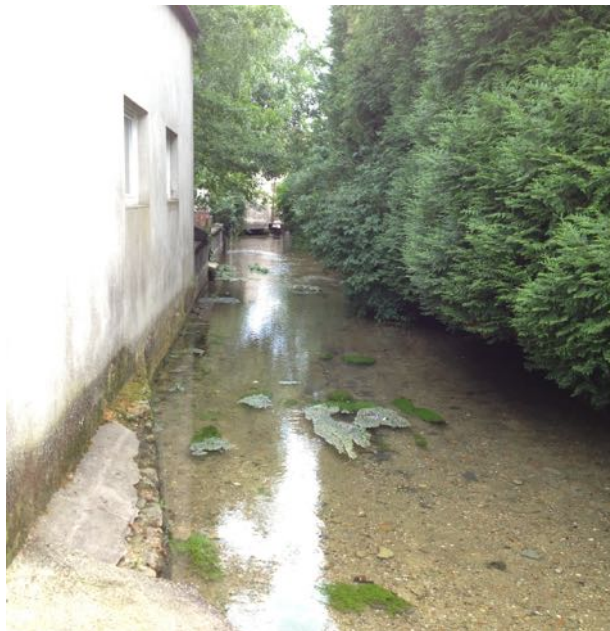
Figure 34 : le ruisseau de la Bouillante au pied des habitations, à l'est du site UFP-Milandri
