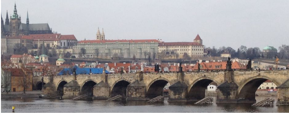
Figure 45 : Prague, Pont Charles (Karlův most) structures en bois en amont des piles pour réduire les risques de barrage que peuvent créer les éléments charriés (photo L. Dupont, 2014)
