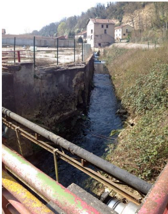
Figure 33 : vues du site UFP - Milandri et de la Bouillante, près de sa jonction avec un bras de la Moselle
