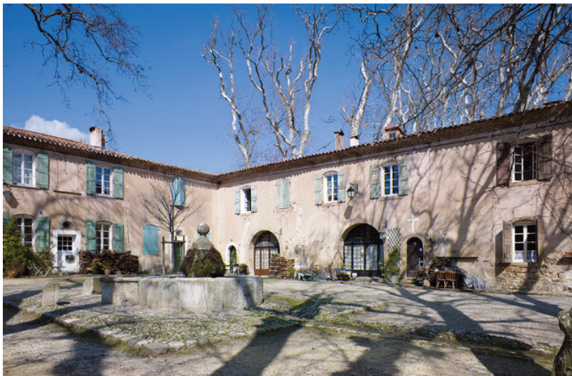
Fig. 27. Villeneuvevrette (Hérault), logements et magasins de l'ancienne manufacture royale ; place Louis XIV. Marc Kérignard © Région Languedoc-Roussillon, Inventaire général.
