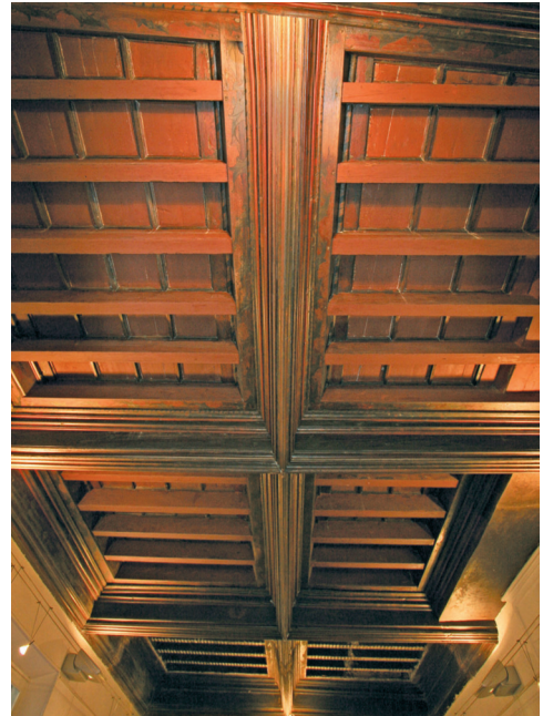
Fig. 17. Lagrasse (Aude), Maison du patrimoine ; plafond à caissons du rez-de-chaussée. © Jean-Pierre Sarret.
