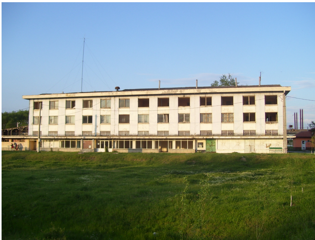
Figure 6. Bâtiment construit dans les années 1960 pour loger la main d'œuvre impliquée dans la récolte du roseau.
