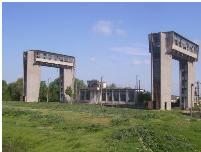
Figure 5. L'écluse de Pardina.
