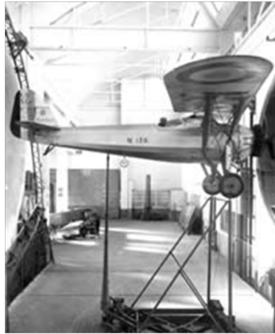
Figure 20 : Essais d'un Morane-Saulnier 315 dans la soufflerie S1 de Chalais-Meudon (1936) [Musée de l'Air et de l'Espace].
