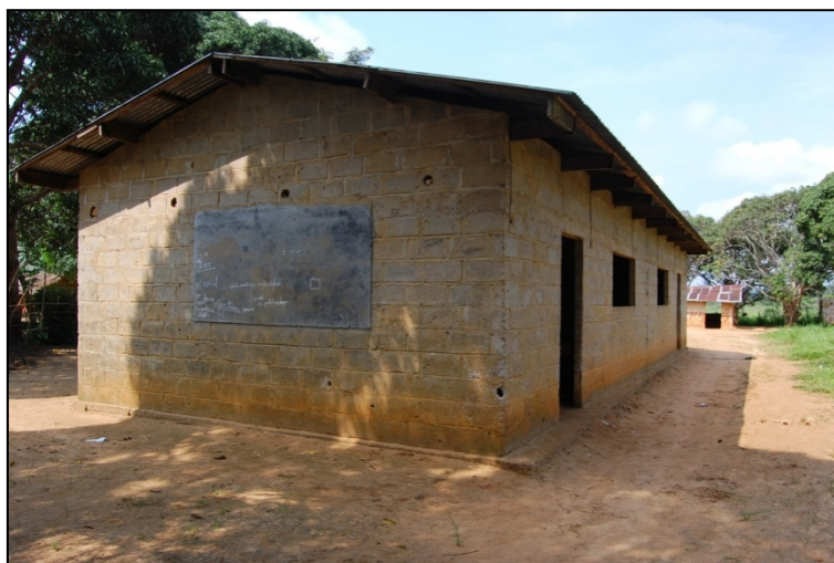
Photo 62. Un des 2 bâtiments de l'école primaire de Mounoko
