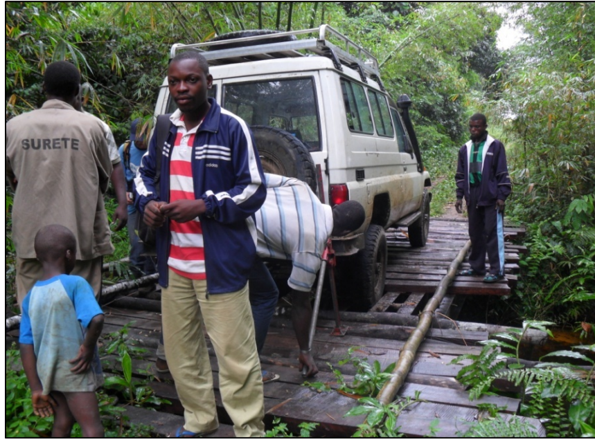
Photo 22. Pont artisanal construit au niveau de la rivière Madzaka (piste Madzaka-Loukouo)
