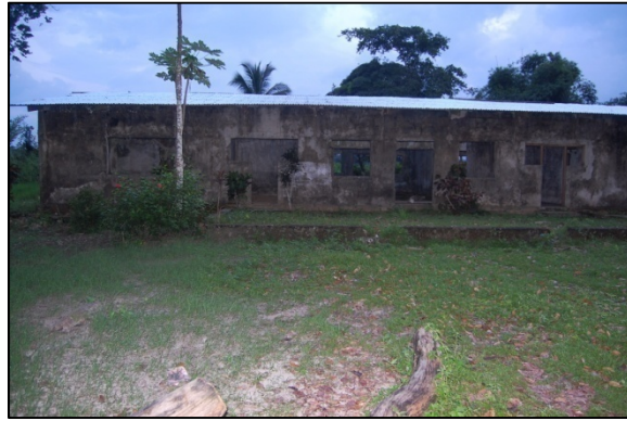
Photo 18. Bâtiment de la paroisse catholique récemment « retôlé » (2010)
