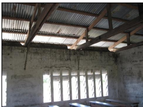
Photo 59. Les murs sont également en mauvais état mais le toit a été reconstruit récemment (l'état de la charpente et des tôles en atteste) :
