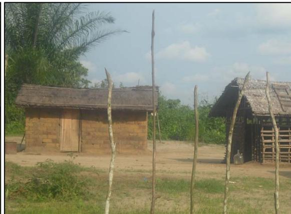
Photo 40. Une des rares constructions en brique d'adobe dans le village d'Impouou
