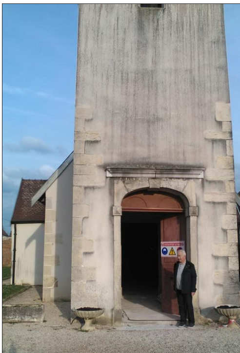
■ Les travaux entrepris dans l'église se termineront vers la fin du mois de juin. Photo Bruno SYLVESTRE
