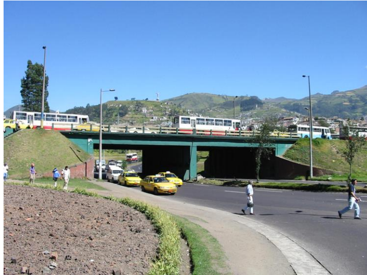
Ejemplo de intercambiador (El Trébol)
