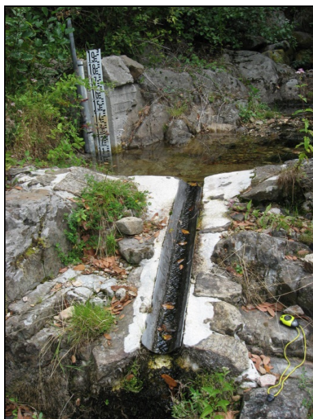
Photo 1- La station des Abrits le 23/8/2011 au plus fort de l'étiage.
