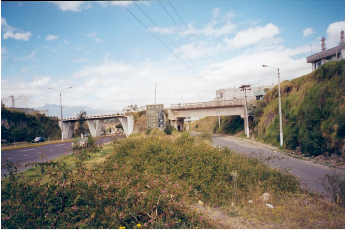
Puente 70 y 71 – vista b Regreso Listado
