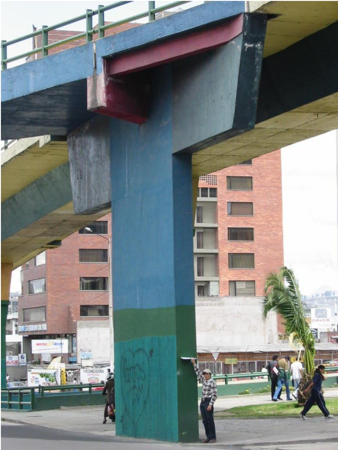
Puente 83 y 13 – vista b Regreso Listado
