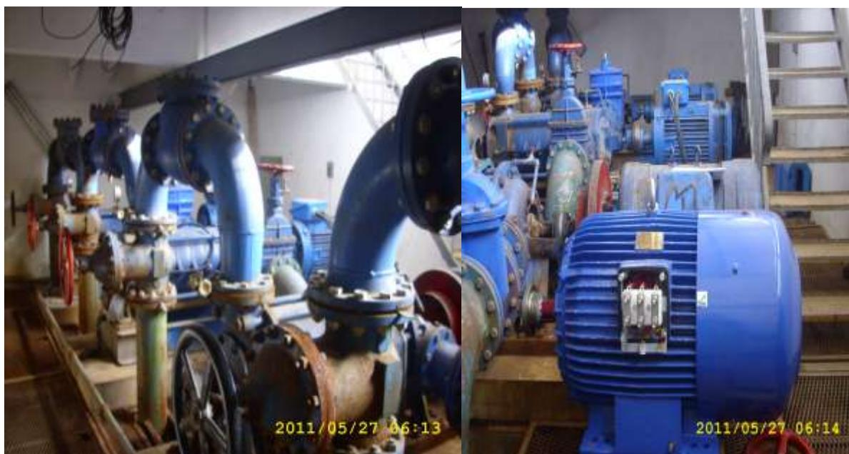
**La prise d'eau du canal du Caïre : système d'irrigation sous pression**
