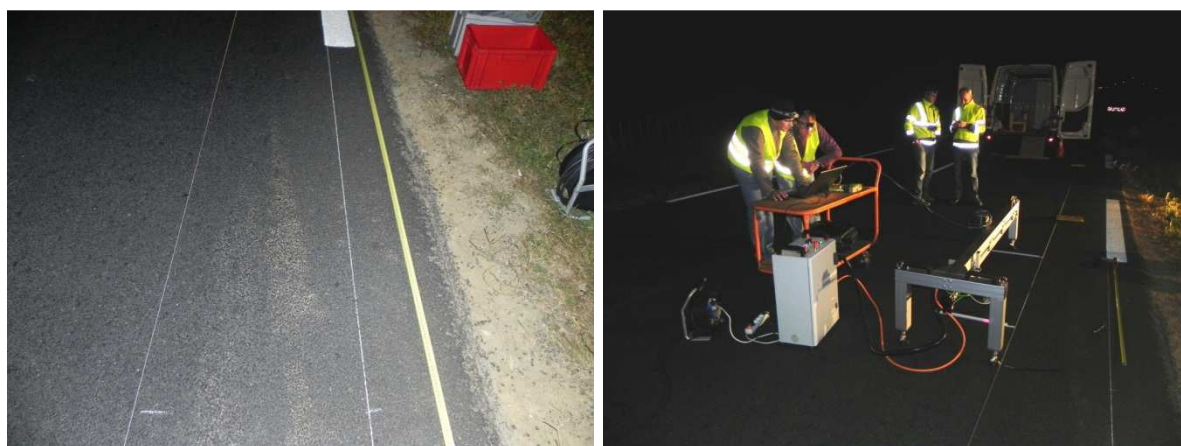
Figure 30 : Implantation des profils de mesure sur le point de référence de la RD 911
