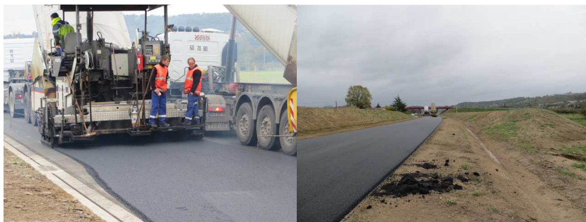
Figure 15 : Mise en œuvre des procédés VIAPHONE® sur le chantier de la RD 911
