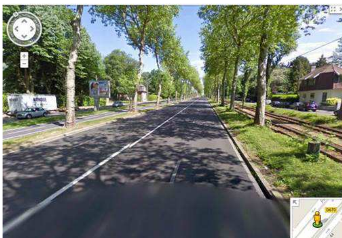
Figure 10 : Revêtement Nanosoft à Mouvaux
