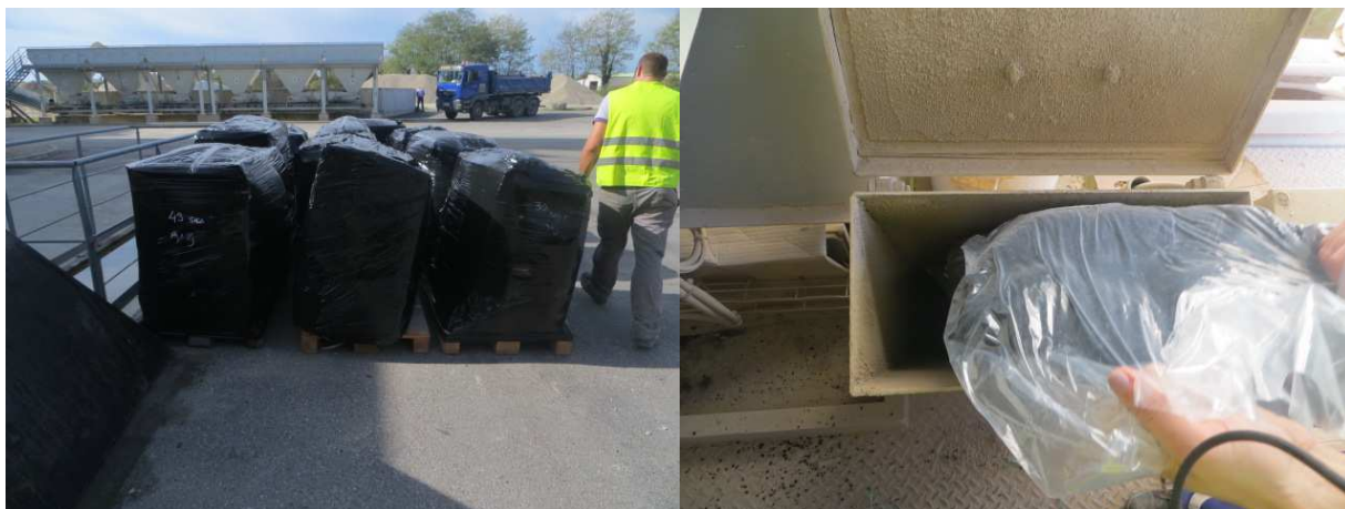
Figure 14 : Centrale d'enrobage LGE de Marmande - Additif X1 conditionné en sacs sur palettes (gauche) et incorporation de l'additif par la trappe d'introduction du malaxeur avant l'injection du bitume (droite).
