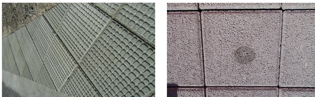
Figure 5 : Solution avec des pavés texturés (a) ; Solution avec des pavés en béton de ciment poreux (b)
