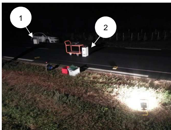
Figure 29 : Essai de texture sur le point de référence de la RD 911 (1- dispositif d'essai EUROVIA, 2- dispositif d'essai IFSTTAR)
