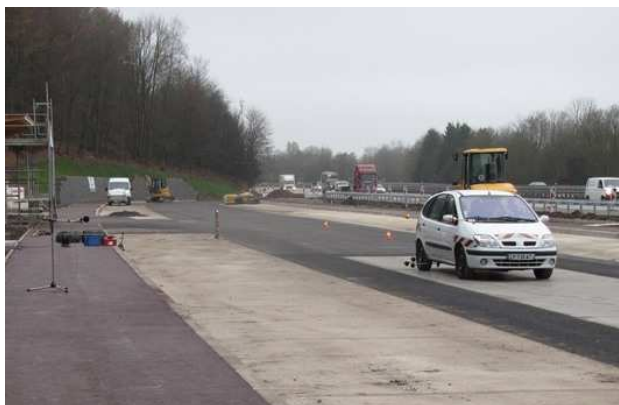
Figure 58 : Exemple de mesure CPX et CB simultanée sur la planche d'essai en UHPC de Meinerzhagen
