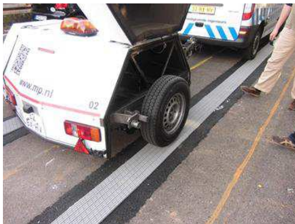
Figure 8 : Matériau mis en place sur site avec la remorque de mesure
