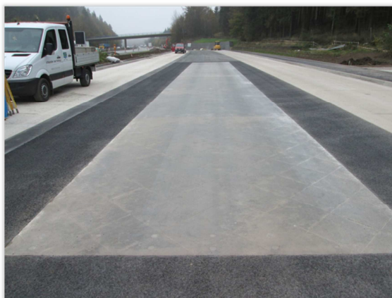
Figure 3 : Réalisation de la planche d'essai sur l'autoroute A45
