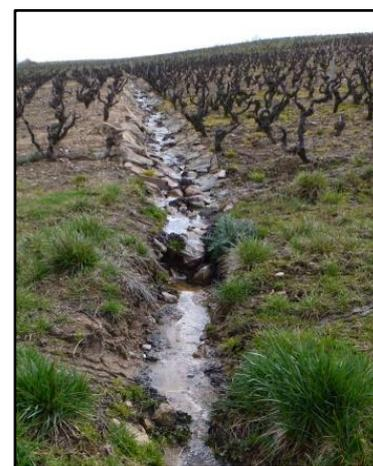
Figure 10 - Fossé (rase du Beaujolais) maçonné concentrant les écoulements
