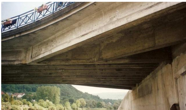
Figure 1 : Vue de la poutre de rive amont et de la structure de l'élargissement en extrémité Rive Droite de l'ancien pont de Clerval sur le Doubs.
