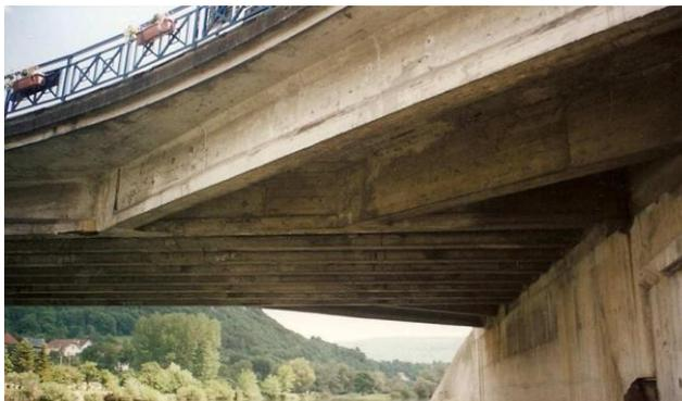
Figure 1 : Vue de la poutre de rive amont et de la structure de l'élargissement en extrémité Rive Droite de l'ancien pont de Clerval sur le Doubs.
