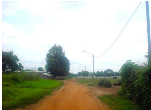
Photo 17: Avenue et réseau d'éclairage public dans le CQ Paroisse.
