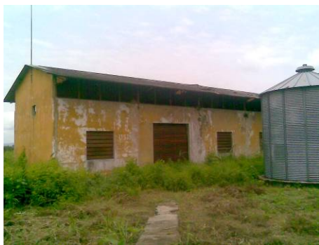
bâtiment des machines
