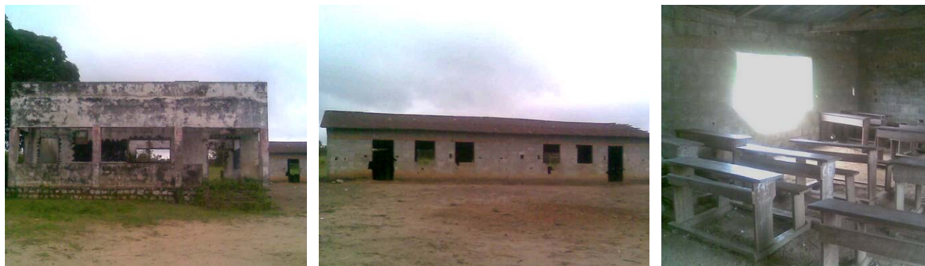
Photos 41 : l'état des locaux de l'école de Loukouo.
