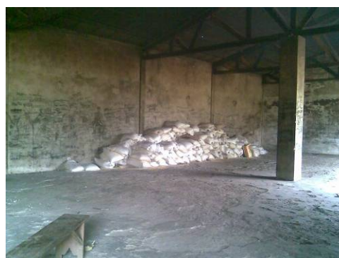
hangar étanche (toiture réhabilitée)
