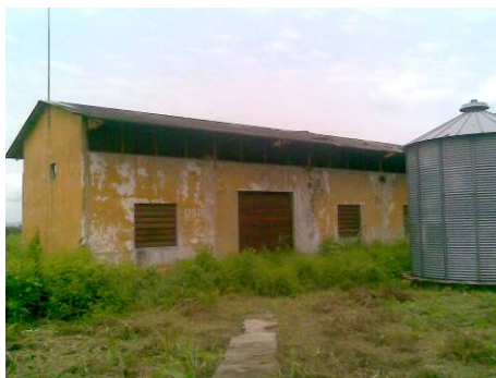
bâtiment des machines
