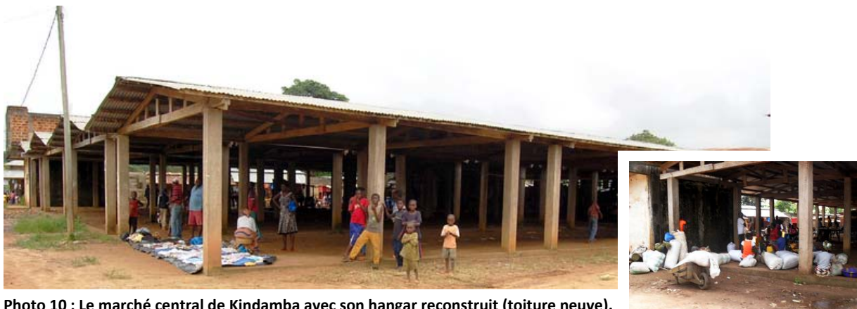
Photo 10 : Le marché central de Kindamba avec son hangar reconstruit (toiture neuve).
