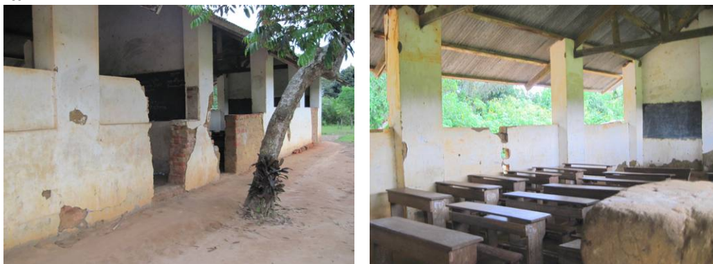
Photo 52 : Les locaux du Centre des Métiers Agricoles (vers le centre de Kindamba).
