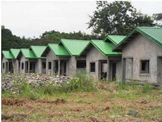
Photo 8 : Logements SoprogI type F3 en attente de finitions. mars 2011.
