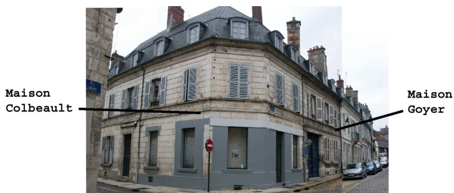
fig.1 Vue actuelle de l'angle de la rue du Four-au-Roi (photo de l'auteur)
