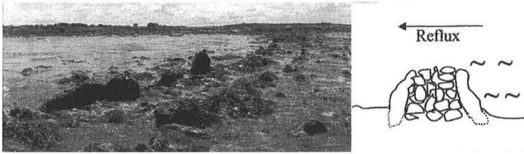
Figure 28 - Barrage n° 6 'Gorred an Drezic' dans le secteur de Theven et coupe théorique du barrage 'Ar gorred coz', Santec, Finistère (d'après Roué et Le Goff, 2008, photo 5, p. 104 et fig. p. 108).
