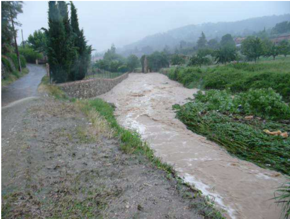
Figure 2. Photo de la section considérée sur la Tuilière à l'aval direct du village de Figanières, prise le 15/6 vers 19h00 (soit après la pointe). Le niveau maximum a atteint 20cm sous la crête du mur situé en rive gauche de la section (pas de débordement constaté au dessus du mur).
