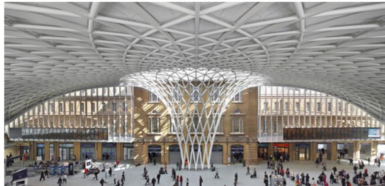
services proposés. La nouvelle halle côté ouest, qui couvre 7 500 mètres carrés au sol et s'élève à 20 mètres est composée de seize colonnes en acier dont la forme est apparente à la silhouette d'un arbre.
