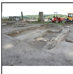
Tranchée : Vue oblique après décapage (sect 3W).
