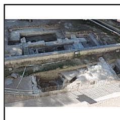
Tranchée : Vue de l'ensemble de la fouille (fin 3e semaine).
