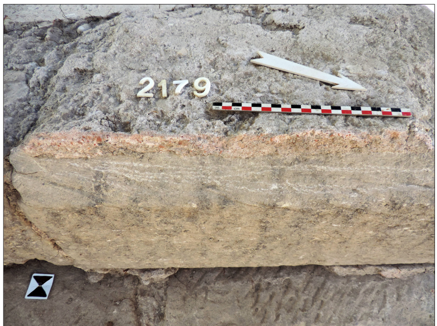
Figure 69 : Détail des joints surhaussés de mortier de tuileau de la reprise du parement nord de M109
