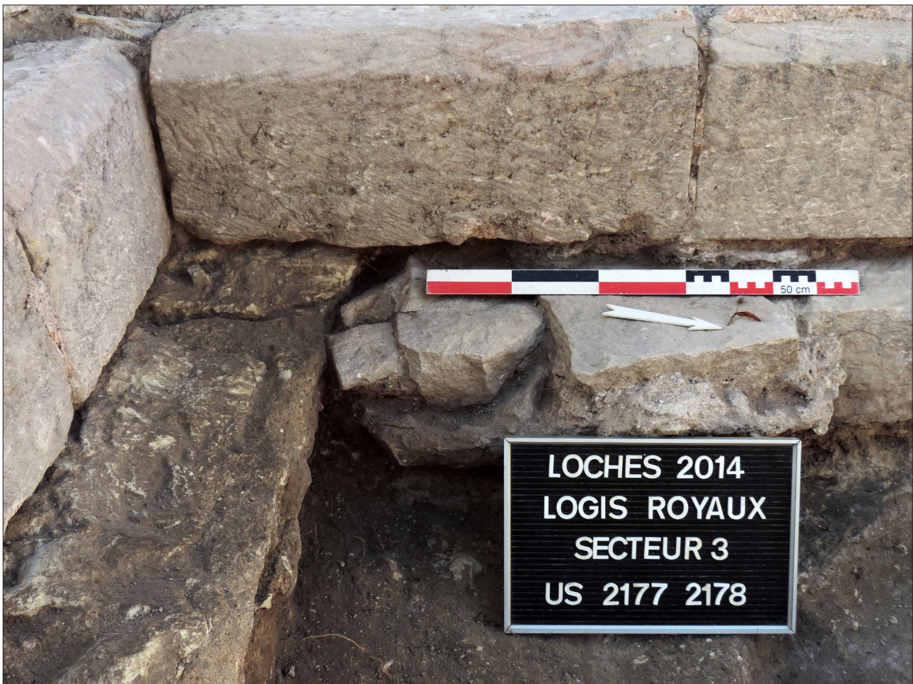
Figure 70 : Détails des reprises en sous œuvre des fondations du contrefort nord-ouest du mur M109
