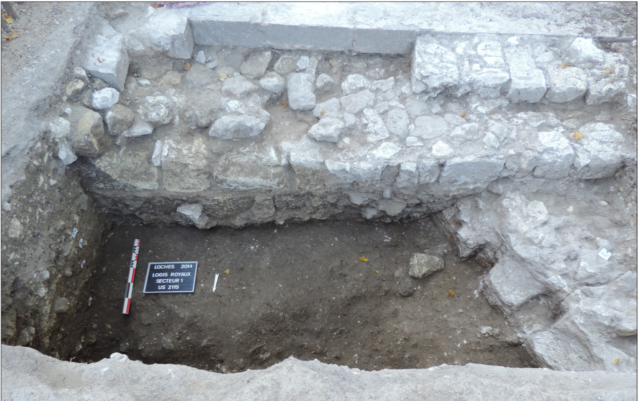
Figure 57 : Vue des fondations du mur M101, au nord
