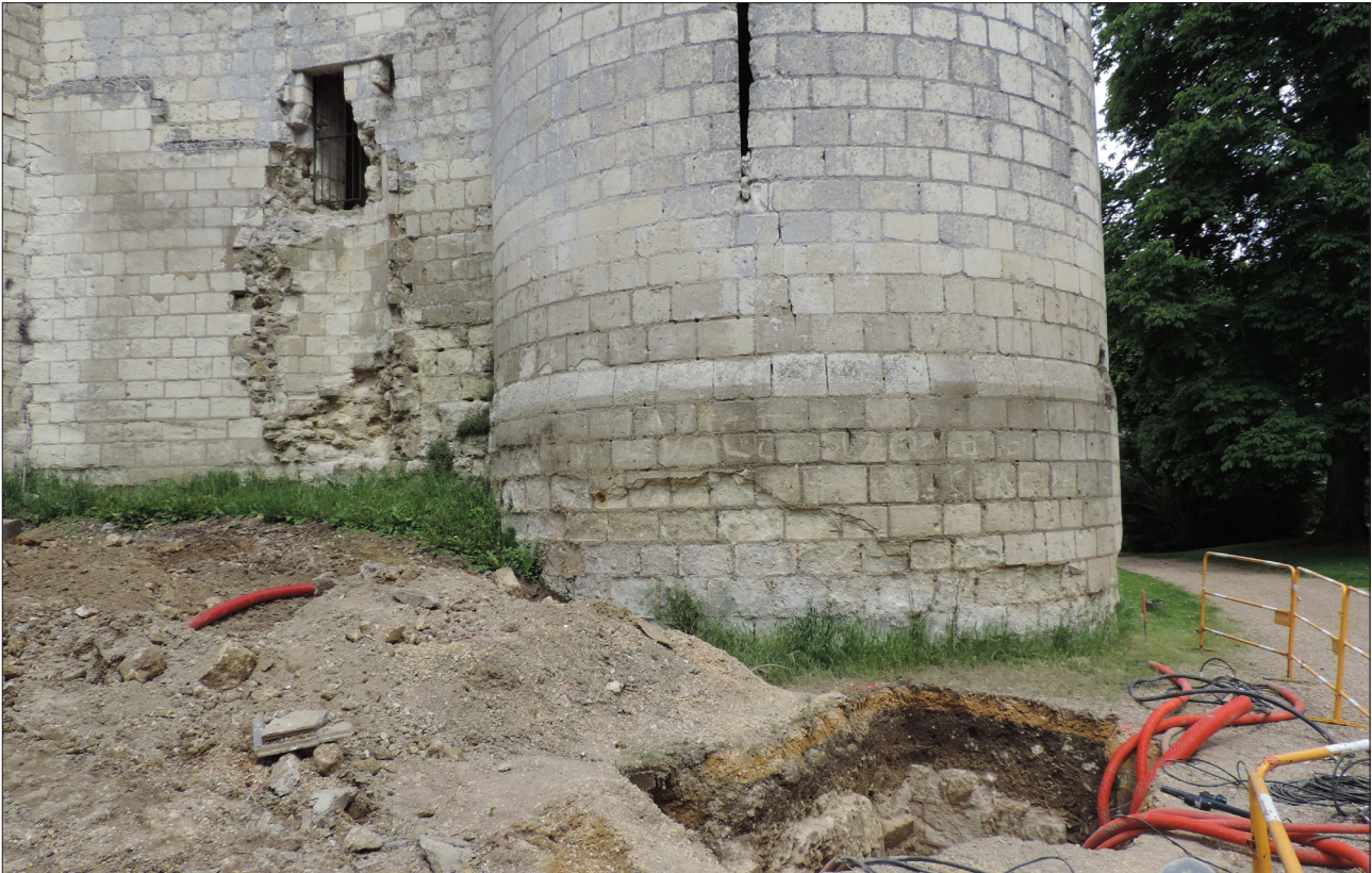
Fig. 12 : Vue de la base de la tour « Philippe Auguste » et de sa courtine attenante à gauche, avec l'arrachement de l'escalier à vis
