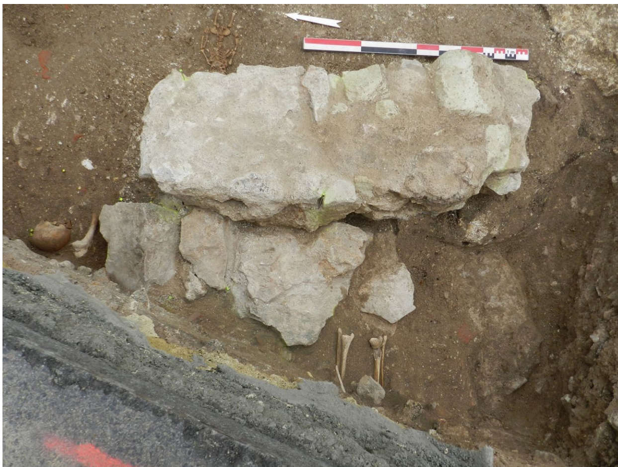
Figure 104 : photographie du mur M3 (en haut) et M4 (en bas)
