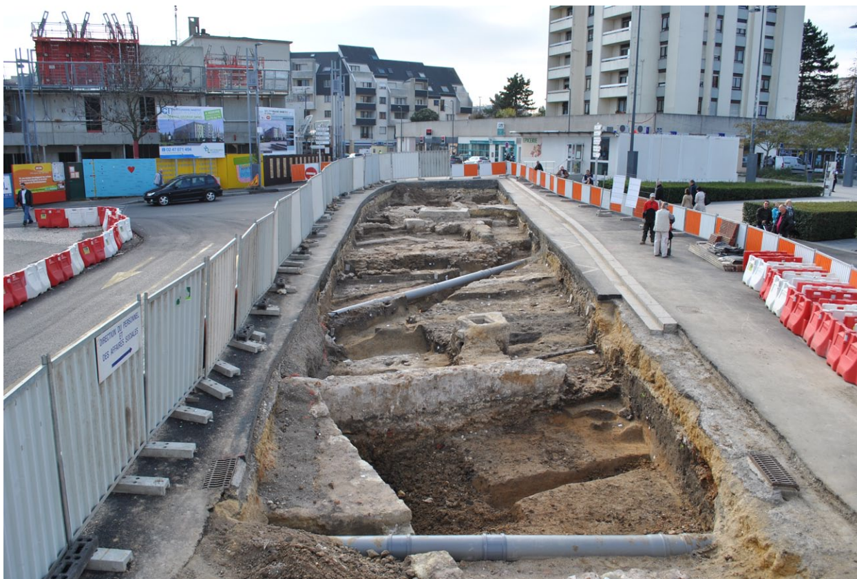
Figure 7 : photographie de l'ouverture de la tranchée ferme (zones 1 à 3)
