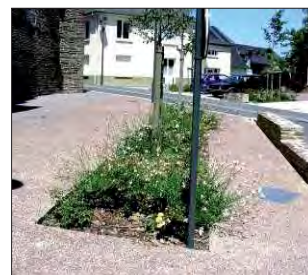
Photo n°4 : Un aménagement de massif : pas de bordure ni de rupture de revêtement = moins d'entretien
