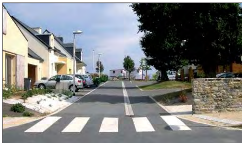
Photo n°8 : Caniveau central sans trottoir ni bordure dans une ruelle de lotissement : limitation de la rupture de revêtement.
