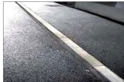
Photo n°9 : Un caniveau sans plaque de fond pour limiter la rupture de revêtement
