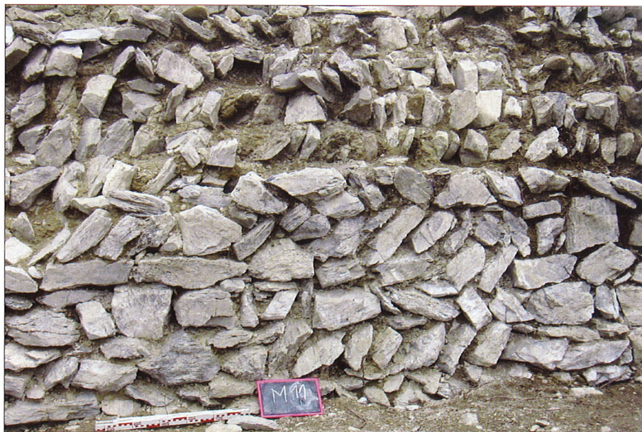
Fig. 7 – Parement externe et cœur du blocage de l'enceinte externe. La mire mesure 50 cm (cl. Fl. Guillot).
