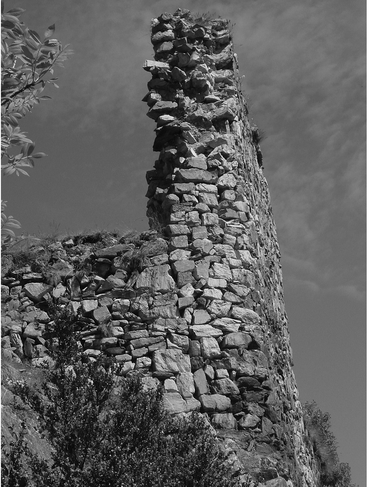
fig. 6. Coup de sabre dans le mur d'enceinte à l'angle formant la tour basse dite du Campanal. Malgré l'absence de chaînage, les murs n'ont pas pu être construits au cours de phases différentes. Il s'agit soit d'une pause de chantier, soit d'une technique volontairement usitée pour éviter que le mur de l'enceinte n'entraîne celui de la tour vers le vide. Crédit Florence Guillot.
