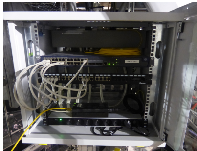
(b) Commutateur placé sur la plaque relié via un transceiver 10Gb/s bidi (simplex)
