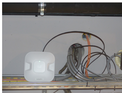
Figure 8: Borne wifi connectée en PoE sur le port interne d'un micro-commutateur
