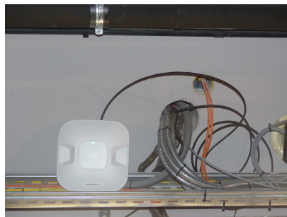
Figure 8: Borne wifi connectée en PoE sur le port interne d'un micro-commutateur
