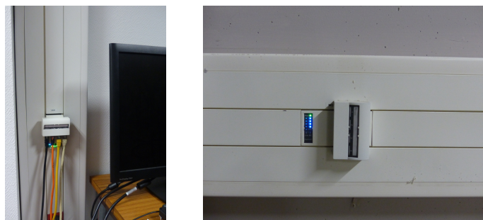
Figure 4: Micro-commutateur administrable intégré dans les goulottes
