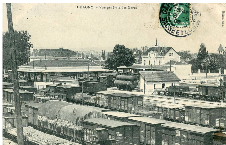
FIGURE 2 – gare de Chagny vers 1900 (source : Wikipédia)
