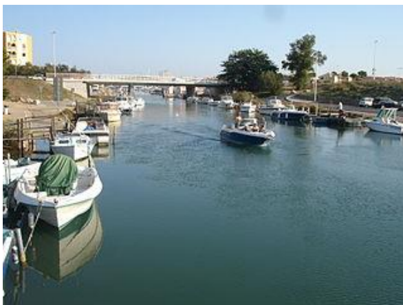
45. Aménagement de l'entrée du port
