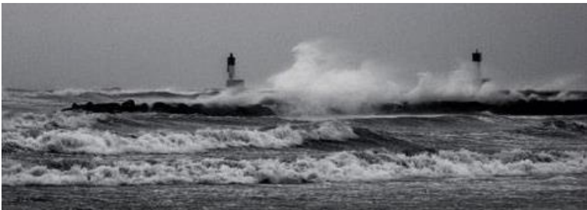
47. Prolongation de l'enrochement en mer du grau
