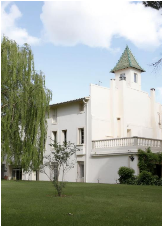
17. Façade de la chapelle Sainte Félicie remaniée en maison de maître.
