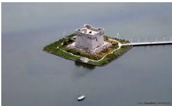
36. Vue aérienne de la redoute du Ballestras, à Palavas les Flots
