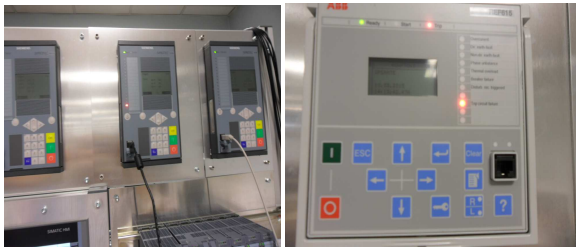
Fig. 4-a Siemens SIPROTEC 5 IEDs, 4-b ABB REF 615 IED
