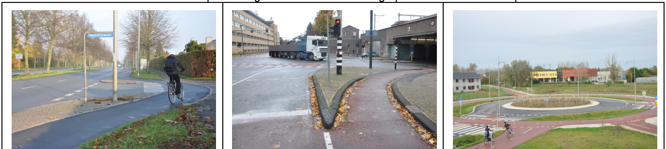
Odense, Danemark : piste cyclable longeant une voirie à 50 km/h déviée pour éviter tout ralentissement aux cyclistes (à gauche) ; Enschede, Pays-Bas : dédoublement de la bande cyclable et aménagement en dur du tourne-à-droite (au milieu) ; Itinéraire rapide F1 Nijmegen-Arnhem : piste bidirectionnelle sur giratoire (à droite)
