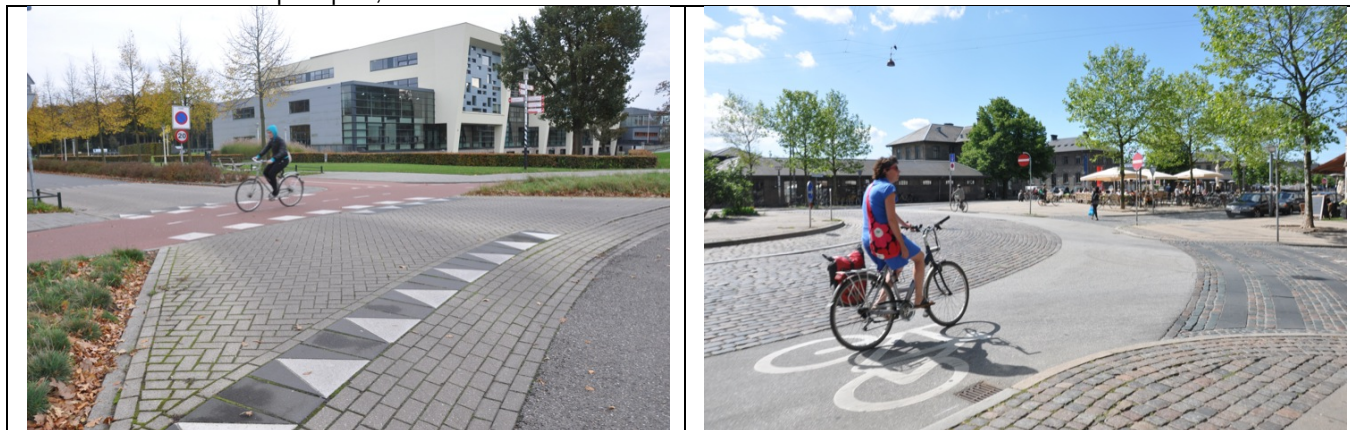
Giratoire équipé près du campus universitaire de Nijmegen (à gauche) ; giratoire en périphérie de Copenhague (à droite) : ici la largeur de la bande cyclable et le pavage des zones automobiles incitent naturellement à des dépassements prudents
