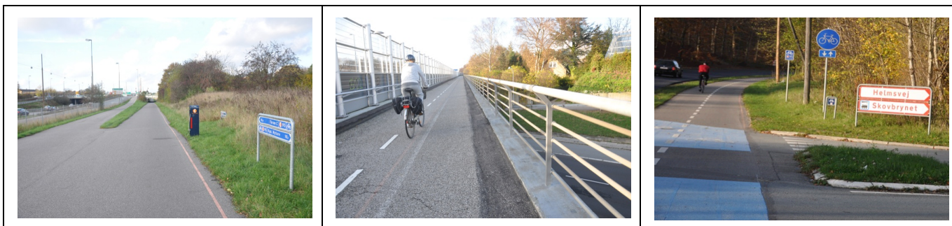
La Farumrute longe l'autoroute sur une partie de son tracé : la voie de droite poursuit sous la voirie de surface, la bretelle de gauche assurant la connectivité ; indications de directions et de distances et pompe à vélo ; passerelle en encorbellement sur la voie de RER ; connexion à la station de Skovbrynet
