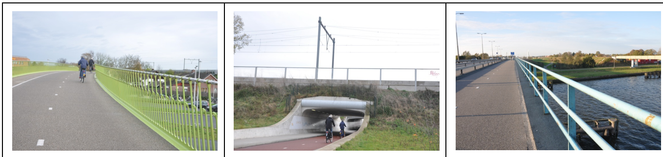
Traitement des coupures : F1 passerelle pour le franchissement de l'autoroute A15 et tunnel permettant de franchir la voie ferrée avant de longer l'autoroute A325 ; franchissement de canal sur l'itinéraire Zwolle-Kampen
