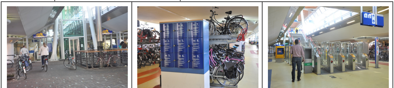
Houten : accès direct depuis l'axe cyclable structurant passant sous la voie de chemin de fer ; vélos sur 2 niveaux et casiers ; escalier intérieur menant directement aux quais
