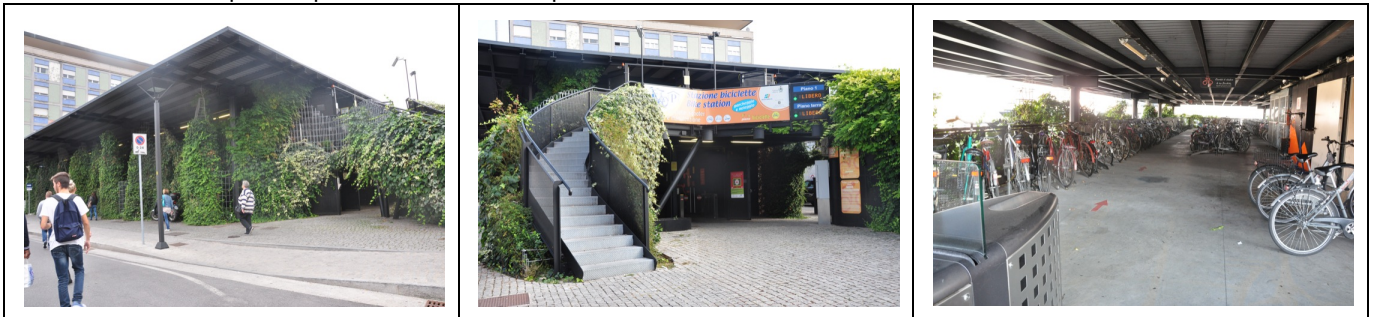
Brescia, gare centrale : la vélostation protégée par grillage et verdure ; l'escalier avec goulottes pour accéder à l'étage ; parking et atelier à l'étage
