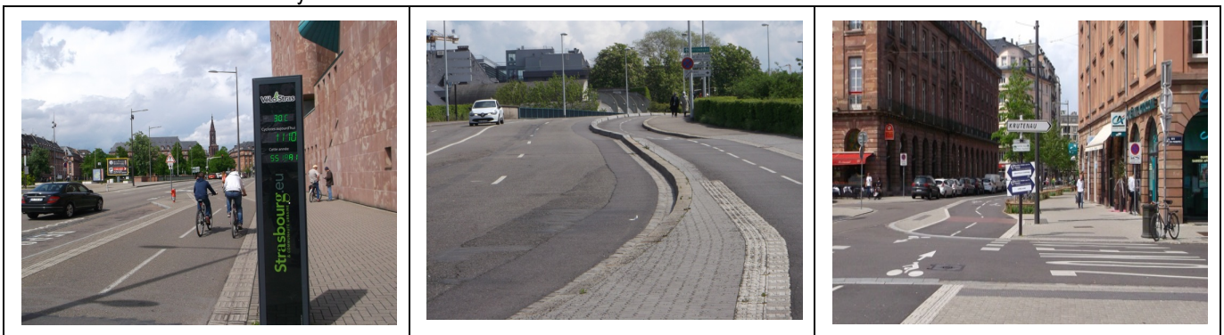
Totem de comptage avec logo VéloStras ; nouvelle piste cyclable bidirectionnelle sur le pont Pasteur ; rue de la Brigade Alsace-Lorraine, axe cyclable prioritaire par rapport aux voies transversales (panneaux cédez-le-passage et marquage Zone 30 sur chaussée)
