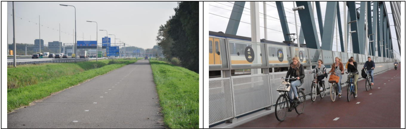
Itinéraires cyclables directs : le F16 parallèle à l'autoroute Rotterdam-Dordrecht ; encorbellement fixé au pont de chemin de fer sur la rivière Waal pour faire passer le F1
