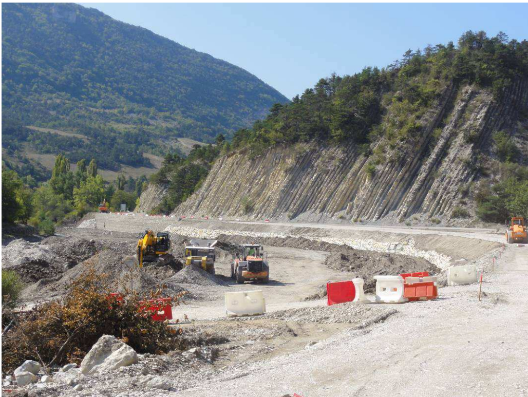
Photo 2 : Travaux sur les berges de la rivière l'Oule en bordure de la nouvelle route D61 ; en arrière plan, la coupe du Serre de l'Âne - @SR.
