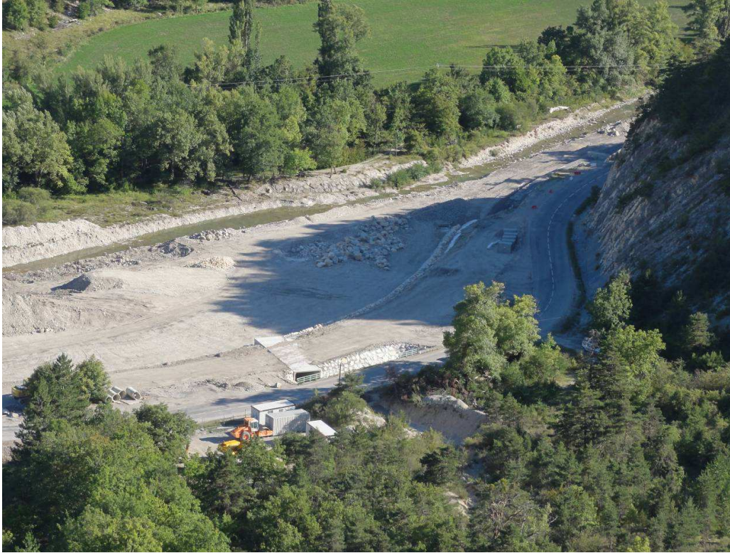
Photo 1 : Travaux de la déviation de la route D61 ; nous voyons l'ancienne route qui passait près de la coupe géologique du Serre de l'Âne et le tracé de la nouvelle voie avec le petit pont en construction qui enjambe le torrent de la combe Reboul ; en arrière plan, la rivière l'Oule - @ S. Reboulet (= @SR).
