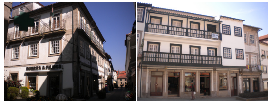
Fots. 1 e 2 - Edifícios característicos de Ponte de Lima. Fonte: MARQUES, 2012.
