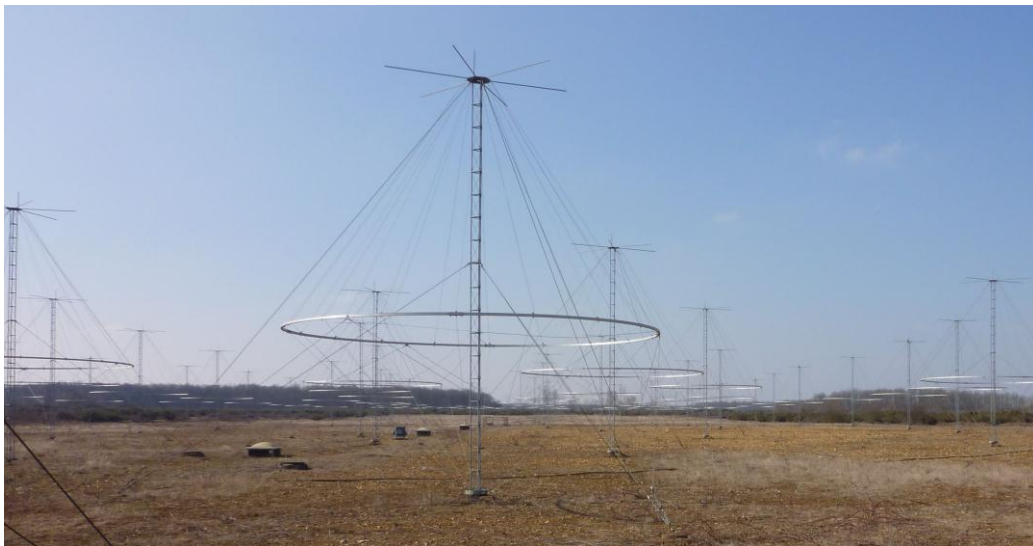
Figure 1: les antennes du radar NOSTRADAMUS
