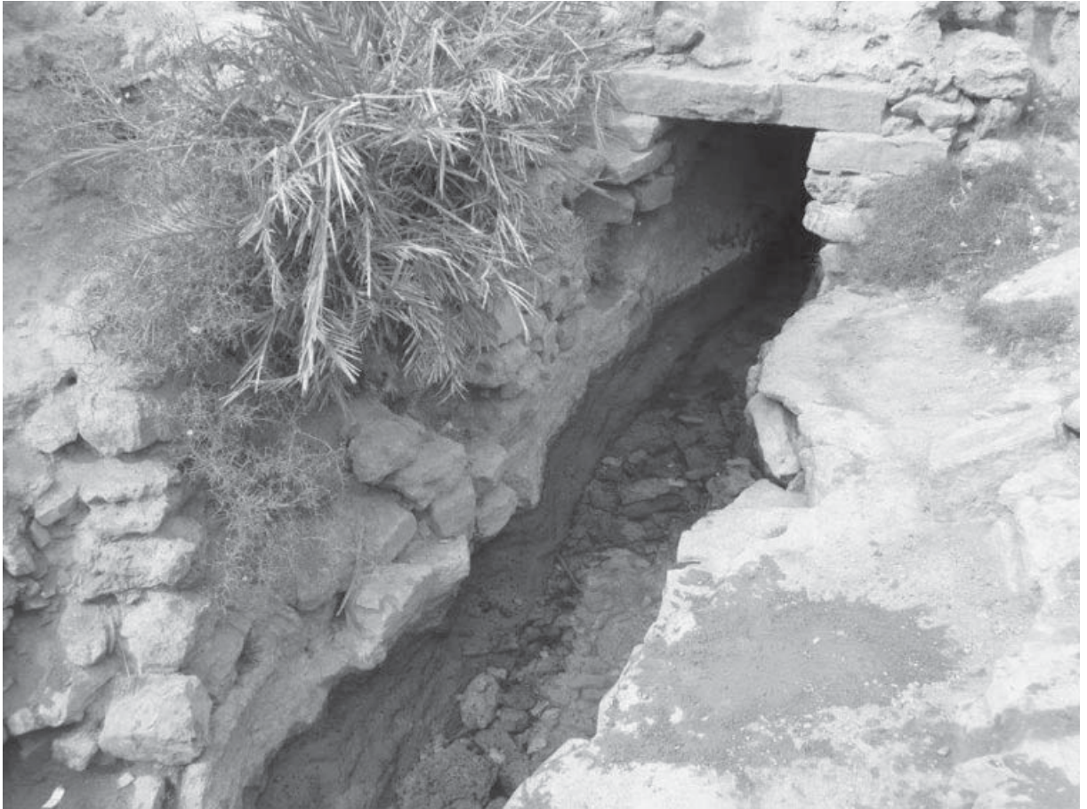
Sortie d'eau d'une khattara . Photo Philippe Jouve.
