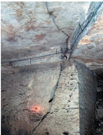
Les *failles de versant* (ou failles de *décompression*) affectent également les *piliers* (fig. 70), déviant le champ de contraintes et générant un effort de cisaillement.
