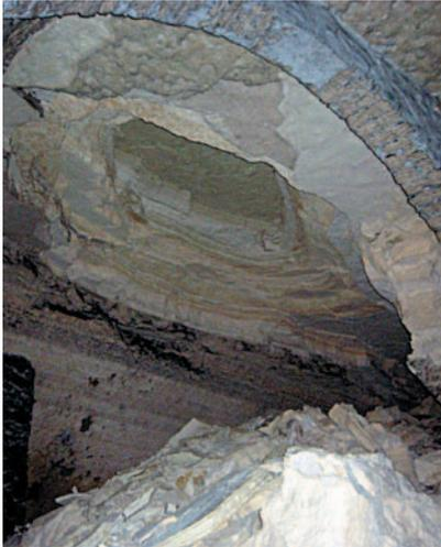
Cette montée du vide peut être stoppée par le foisonnement des matériaux éboulés (auto comblement) ou quand la cloche rencontre un banc plus raide dans les terrains de *recouvrement*. Le phénomène peut être ralenti par des phases d'équilibre transitoires durant lesquelles le sommet de la cavité présente une géométrie en voûte ou « cloche » temporairement stable (fig. 59).
