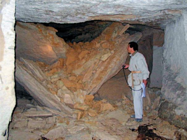
Figure 53 : Chute du toit d'une carrière de calcaire grossier à Méry-sur-Oise (Val-d'oise)
