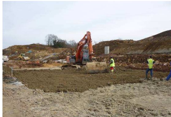
réglage de casiers en argile traitée
