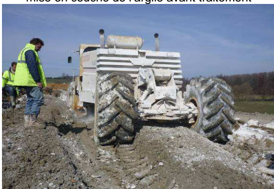
malaxage de l'argile traitée à la chaux
