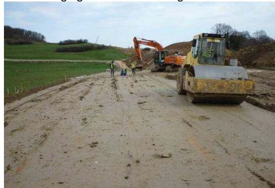
compactage de l'argile traitée au VM5
