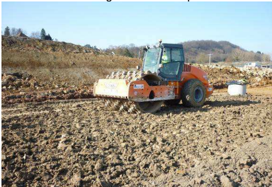
compactage de l'argile traitée au VP5
