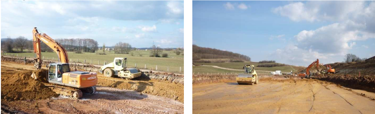
Figure 6 : mise en œuvre de la première couche de remblai sur toute l'emprise de l'ouvrage
