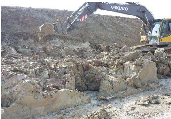
mise en couche de l'argile avant traitement
