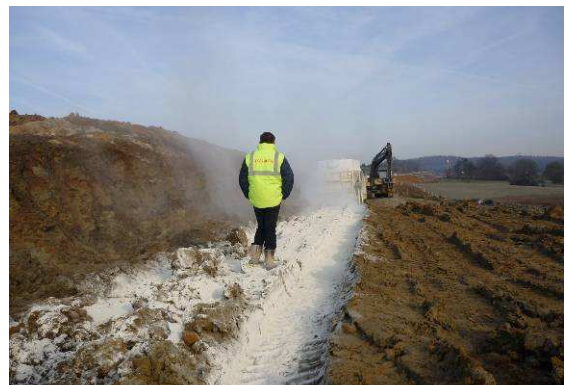
épandage de la chaux sur l'argile
