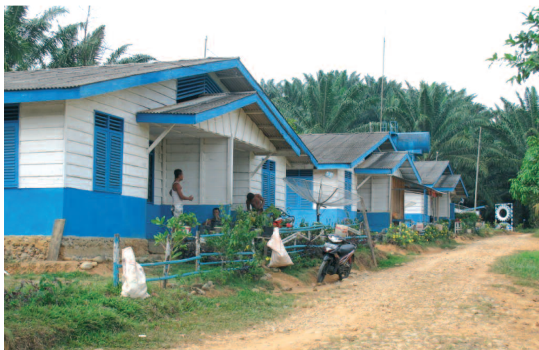
Figure 2 - Maisons d'ouvriers ( pondok ) de la plantation de Bengkulu
