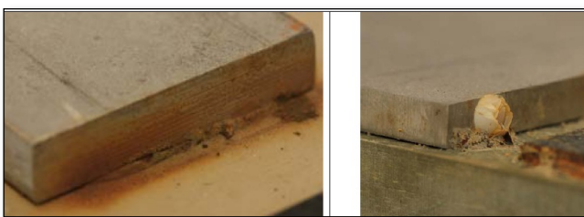
Fig. 8. Stainless steel edge corrosion and biofouling [28].
