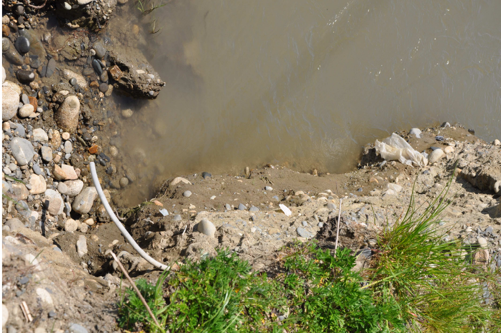
8. Remblais de berge avec des déchets inertes mais dangereux pour l'écosystème : PVC, films plastiques etc.
