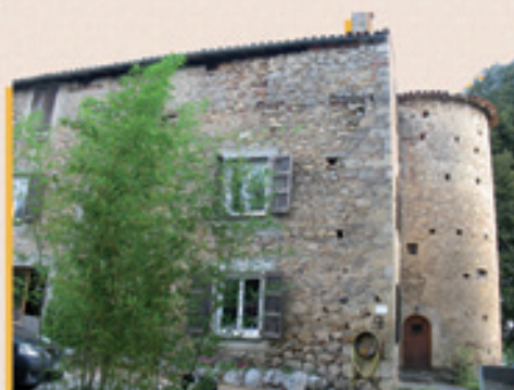
La ferme de Rimont
